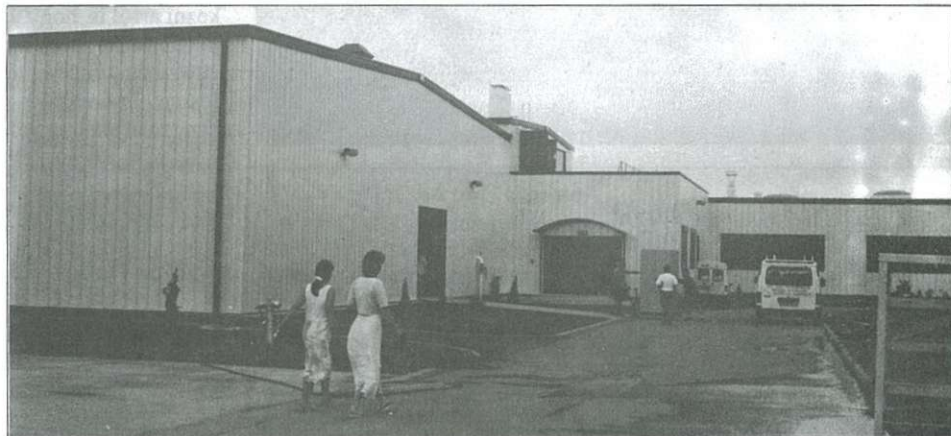
Elkészült a város jelenlegi legnagyobb üzemcsarnoka, amit másfél milliárd forintért építettett a Cellkomp Kft. A cég fejlődéséről részletesen írunk az Új Kemenesalja következő számában.
