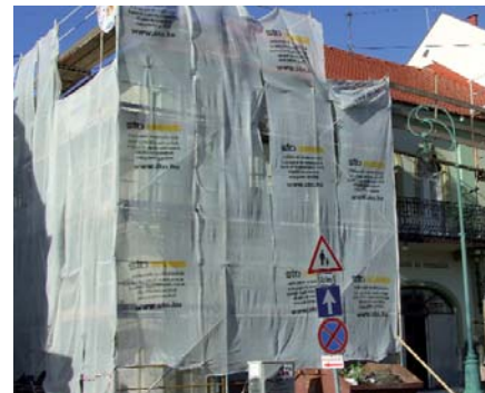
A MEGÚJULÁS ALATT ÁLLÓ ÉPÜLET
