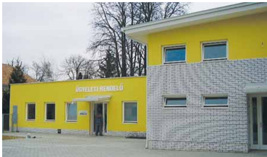
A MENTŐÁLLOMÁS ÉPÜLETÉBEN TALÁLHATÓ ÜGYELETI RENDELŐ
