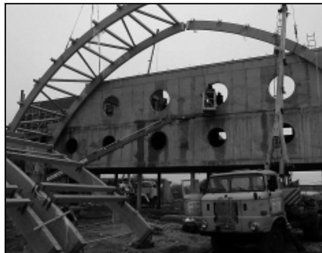
A TETŐSZERKEZETI ELEMETEK RAKJÁK A FÜRDŐ ÉPÜLETÉRE
