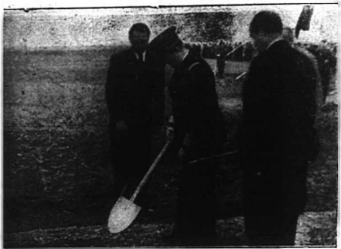
Kormányzó Urunk ásvágásával megkezdődött a Sajó csatorna építése.
